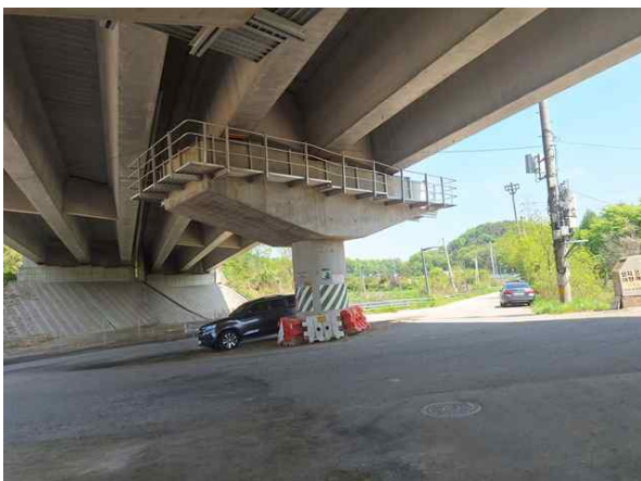
비봉방향 교각 P1 기초 전경
