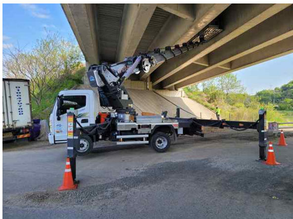
고소작업차를 이용한 근접조사
