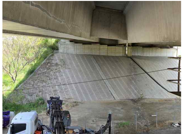
매송방향 교대 A1 기초 전경
