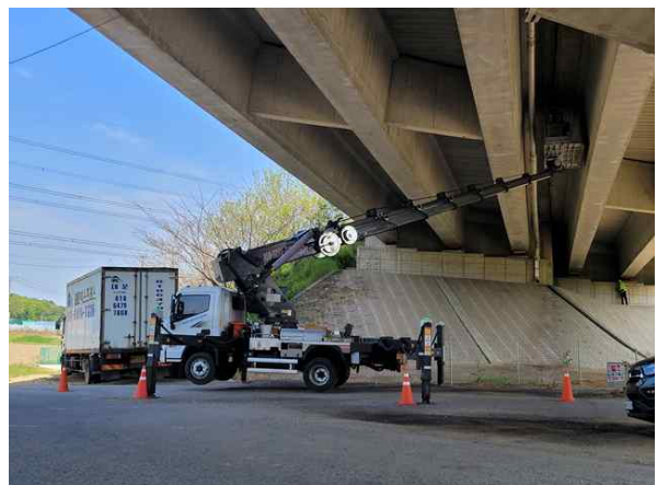
고소작업차를 이용한 근접조사
