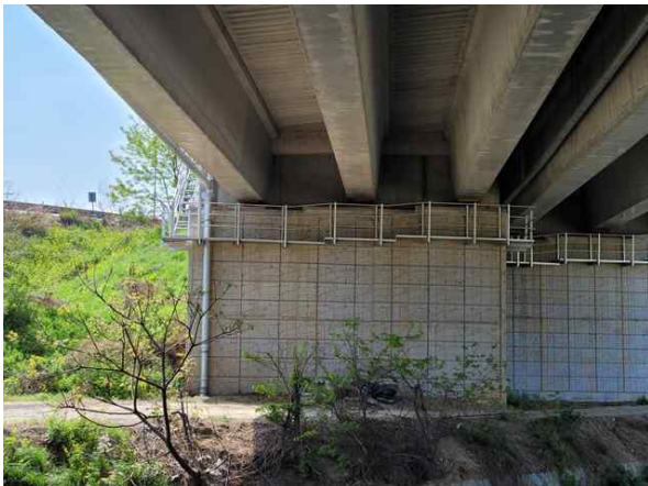
비봉방향 교대 A2 기초 전경
