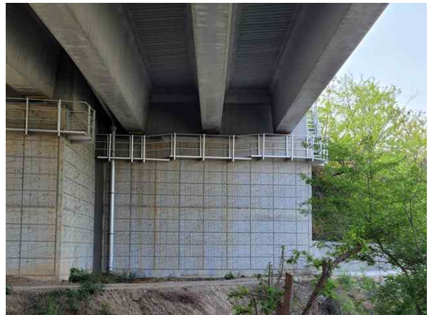
매송방향 교대 A2 기초 전경
