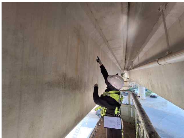
고소작업차를 이용한 부재치수 현장측정
