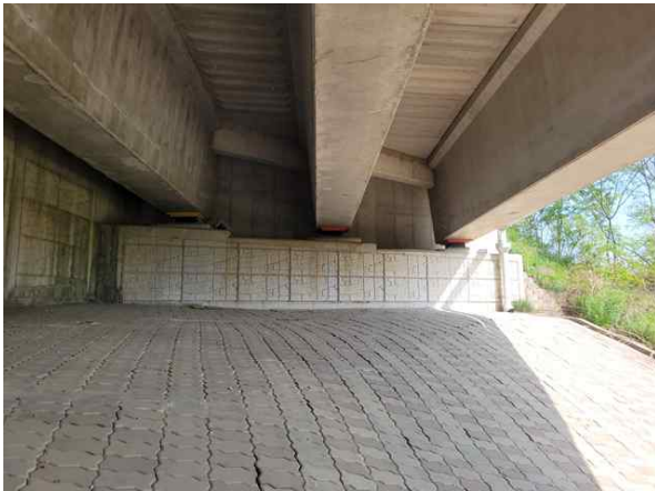
비봉방향 교대 A1 기초 전경
