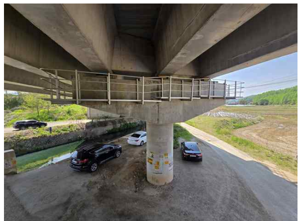
매송방향 교각 P1 기초 전경
